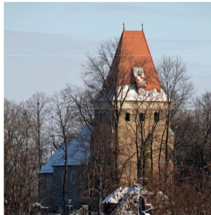
Kirche Hohen Thekla aufgenommen vom Dachgeschoss der Neutzscher Straße 14
