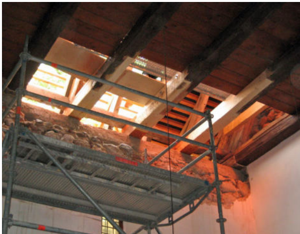
Deckenbalken in Hohen Thekla
