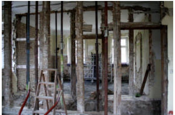
Schön sichtbar auch der Ständerbau des Hauses, Holzbalken, die ausgemauert waren, trugen die Decke und die oberen Etagen. Diese Konstruktion ist statisch nicht ganz einfach zu ersetzen.
