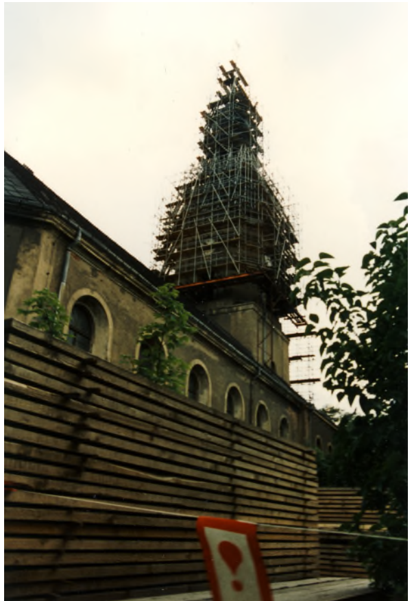
1990 - Der Kirchturm ist vollständig eingerüstet. Das Bauholz für die Turmzwiebel liegt noch auf der Wiese.
