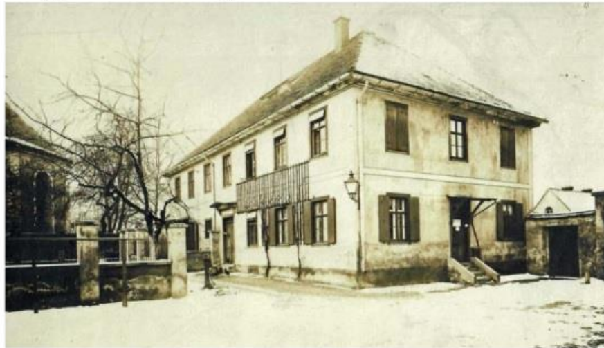
Pfarrhaus Schönefeld vor 1906 (Ansicht von Südosten), - Eingang zum Pfarrhaus an der Südseite, Publikumsingang (Expedition), an der Ostseite - Wirtschaftshof mit Kopfsteinpflaster und Handschwengelpumpe, - Trennungsmauer zwischen Wirtschaftshof und Pfarrgarten
