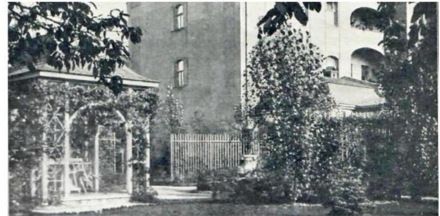
Pfarrgarten Schönefeld nach 1906 (aus A. Stöckel 1912), - mit Gartenpavillon und Vogeltränke im Jugendstil, - Zaun des Hühnerauslaufes und Dach des Waschhauses, - Blick auf die Rückseite des Rathauses
