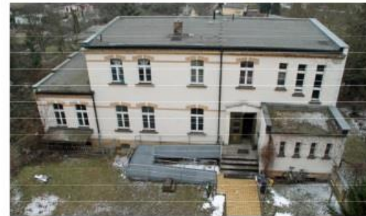
Gemeindehaus im Jahre 2018 mit behindertengerechtem Eingang (Rampe). Aufgenommen vom Wohnhaus Kieler Straße 51 (4. Etage), Blick Richtung Süden.
